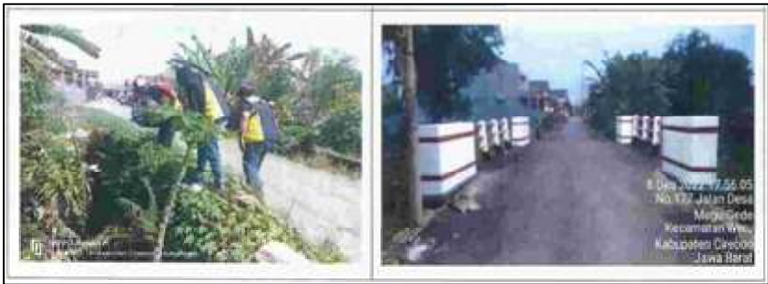
Peningkatan jembatan dan ruas jalan megugede – kecabaian
