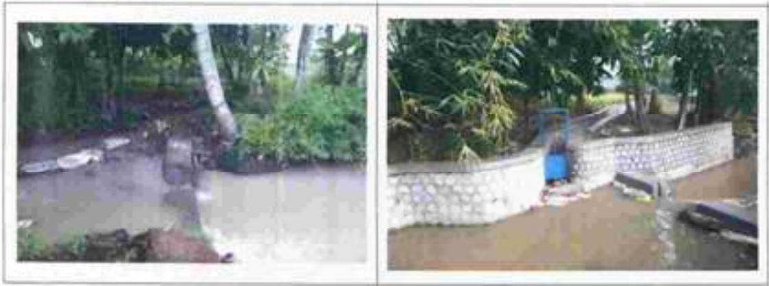
peningkatan bendungan duan jaran Tukbual – Kecamatan Depok
