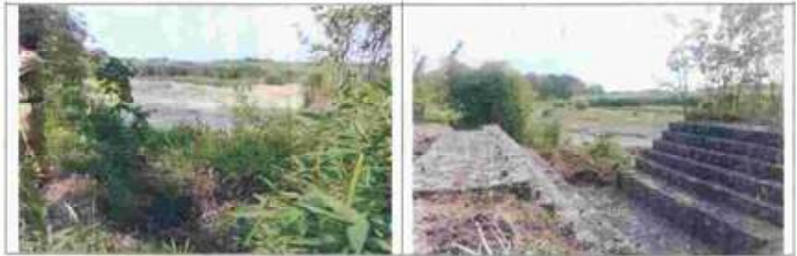
Pemasangan bronjong kali pembuang Tanjunganom anak sungai Cijangkelok blok Getrak Kec. Pasaleman
