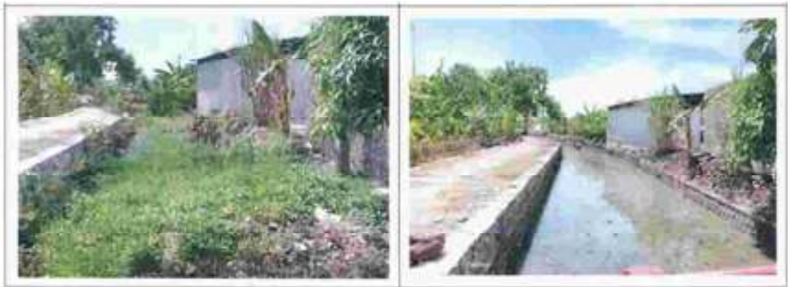
Normalisasi saluran irigasi tersier B.MTR Kecamatan Ciledug.
