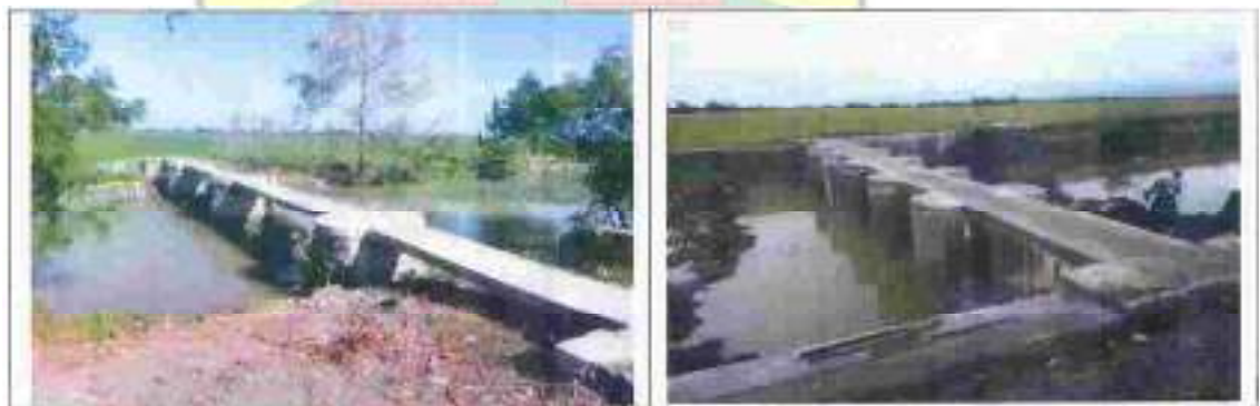
Pembangunan Longstorage DAM Pintu Air Cangkring blok sikacang- Kec. Gegesik
