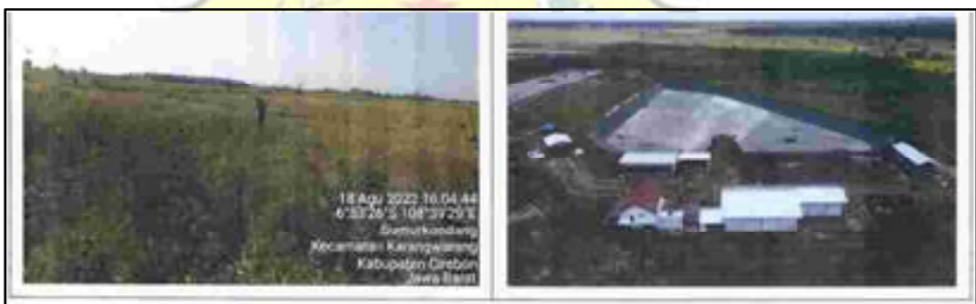
Pembangunan TPA dan Pembangunan Jalan Menuju TPA.
